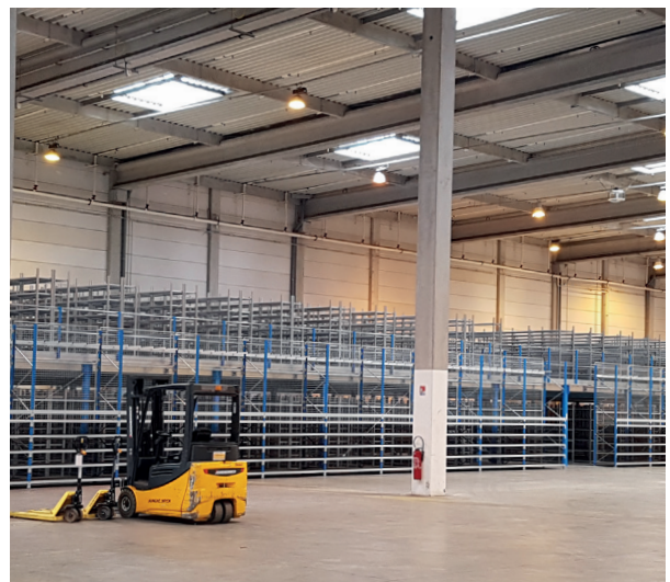
Großanlage mit Regalen und Podesten.
